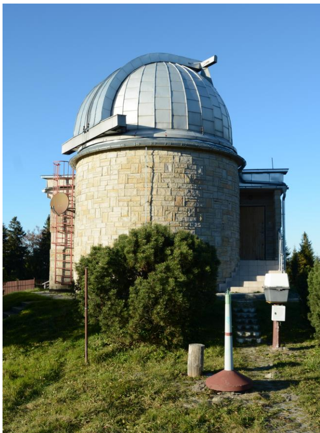
Rys.5 Budynek Obserwatorium z 5-metrową kopułą [fot. M. Dróżdż]
